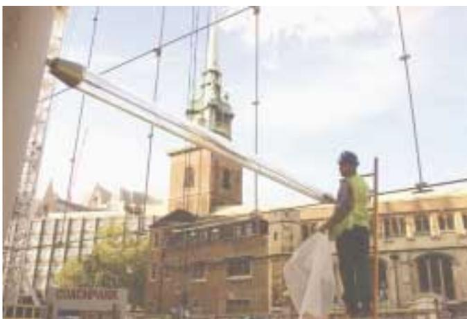
**Bild 6:** Die ersten Verbundglasrohre wurden im Londoner Tower-Place-Projekt zur Abstützung zweier großer Glasfassaden eingesetzt
