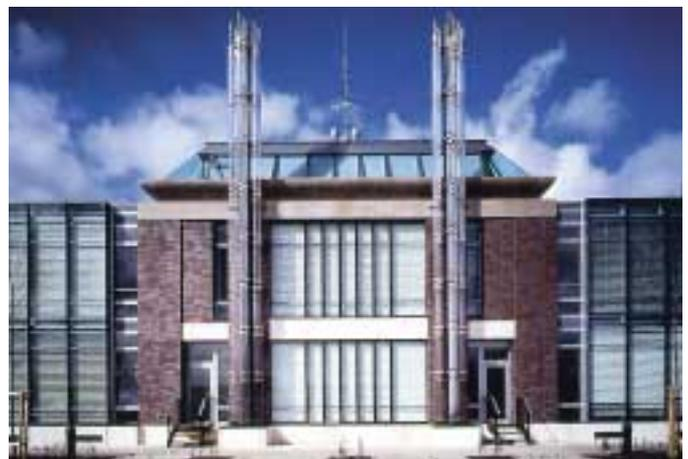
**Bild 3:** Schott-Rohrglas begann Ende der 80er Jahre mit der Entwicklung von Glasschornsteinen. Diese sind nicht nur sehr ansprechend in ihrem ästhetischen Erscheinen, sondern auch in der Lage, aggressive Rauchgase abzuleiten
