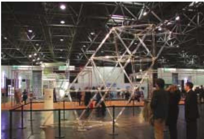
**Bild 5:** Das gläserne Raumfachwerk entstand nach einem Entwurf von Friedrich Wagner zusammen mit der Firma Mero und wurde auf der glasstec 2000 vorgestellt
