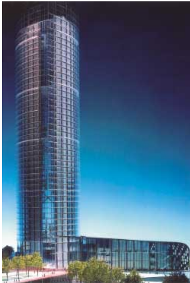
Der ellipsenförmige Post-Tower hat eine vollverglaste Doppelfassade
