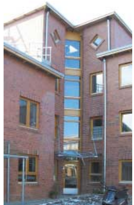
„Rekord“-verdächtige Fenstermontage in Niedrigenergie- und Passivhäusern am Brachvogelweg in Hamburg-Lurup
