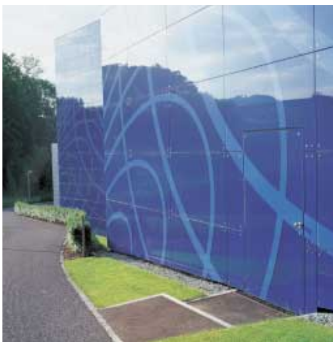
Mit Siebdruck gestaltete Glasfassade
