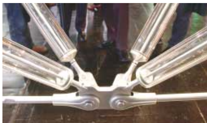
Bild 4: Knotendetail der Glasrohrbrücke
