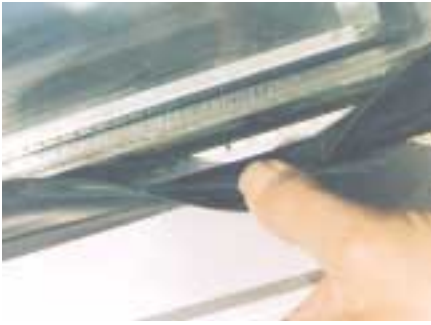
Bild 8: Die Verglasungen sind von der Außenseite her an den Dachprofilen durch Lippendichtungen abgedeckt
