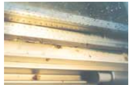
Bild 6: Wasser im Glasfalz setzt die Wärmedämmwirkung der Isolierglasscheibe stark herab
