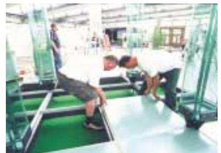
Als letztes werden die begehbaren Glasplatten für den Boden eingelegt
