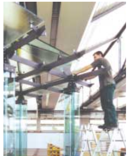
Nachdem die Glasstützen aufgestellt sind, kommt der Dachaufbau an die Reihe
