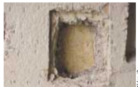
Durchbruchversuch bei einem mehrschichtigen Wandaufbau, WK 3
