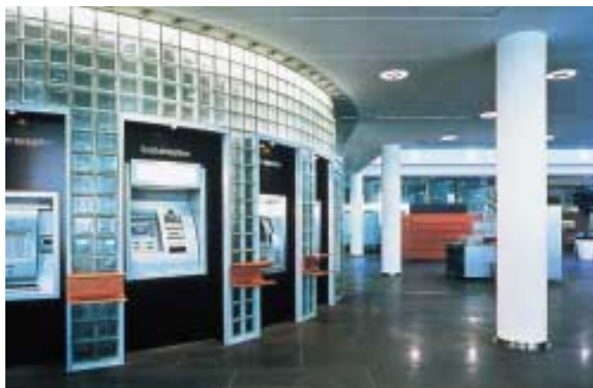
Durchschußsichere „Solaris“-Glassteine eignen sich gut für den Einsatz in Banken, hier mit runden „Solaris“-Glassteinen als gebogene Glaswand ausgeführt
