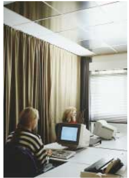
Bild 5: Das Spiegelreflektorprinzip für Lichtumlenkung und gleichzeitigen Blendschutz reduzieren die Außenleuchtdichte am Fenster auf 200 bis 300 cd/m 2 . Durch Lochung ist die Sicht nach außen ausreichend möglich und liefert eine gleichmäßig verteilte Lichtmenge von TQ 3 % als Mittelwert
