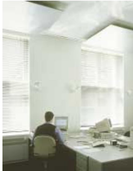
Bild 6: Doppelsystem mit Lichtlenkung und Ausblendung
