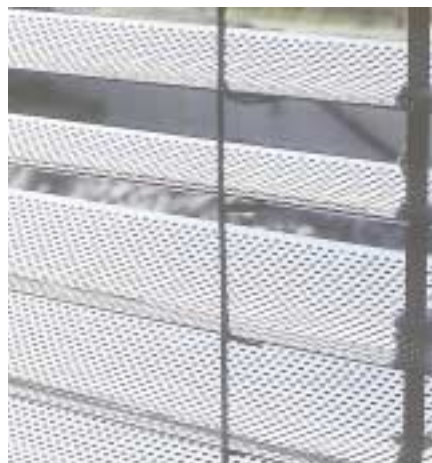
Bild 4: Detail Umlenkklammer gelocht
