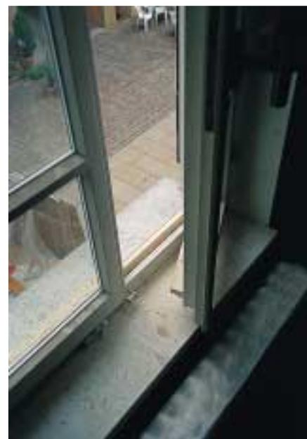
Die spezielle Isolierglasscheibe für Renovationen ist kaum von einer Einfach-Scheibe zu unterscheiden
