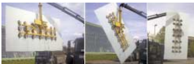
Baustellenverglasung mit einem Pannkoke Handlinggerät: zu sehen ist die Drehung einer 1800 kg schweren Spezial-Isolierglasscheibe mit VSG-Milchglas
