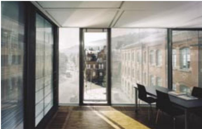
**Transparenz trotz Sonnenschutz: Das Lichtlenksystem im Isolierglas ermöglicht gute Ausblicke. In der Bildmitte ein Parallel-Ausstellfenster mit Klarglas Marke Schüco**
