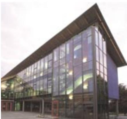
Türen aus der Serie „Systherm 72 E“ zeichnen sich durch ihre schmale Bautiefe von nur 72 mm und durch einen Wärmedurchgangskoeffizienten im Bereich von 1,8 bis 2,2 W/m<sup>2</sup>K aus
