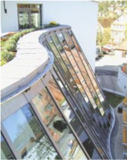
Eine geschwungene Fassade läßt sich mit der „Face 50“-Fassadenkonstruktion genauso leicht umsetzen wie gerade Formen
