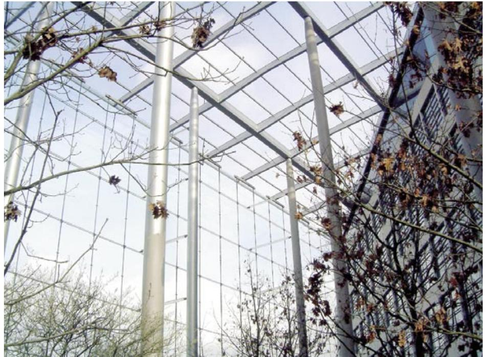
Bild 1: Fassade des Tower Place, London: hier kamen tragende Glasrohre erstmals zum Einsatz
