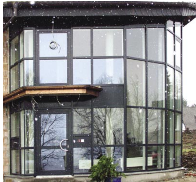
Bild 1: Ansicht der Front der Fassade
