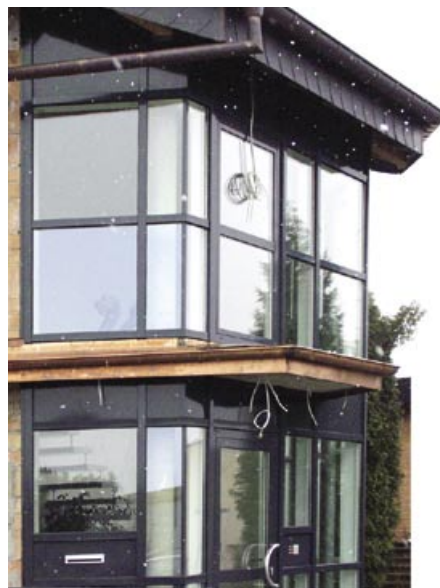
Bild 2: Ansicht der linken Seite der Fassade
