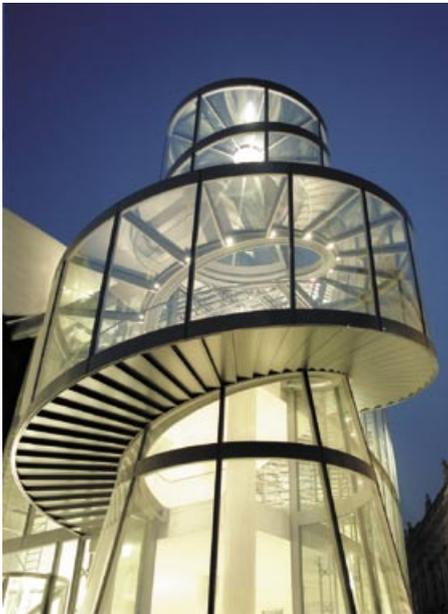
Das Meisterstück bei der Fassadengestaltung ist der Treppenturm mit seinen doppelgekrümmten Isolierglasscheiben. Für jede dieser gebogenen Scheiben mußte eine eigene Biegeform hergestellt werden.
