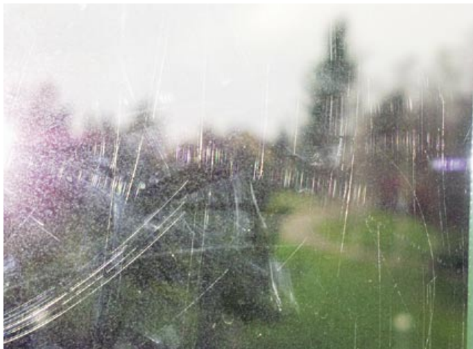
Bild 1: Derartig stark zerkratzte ESG-Scheiben werden leider immer häufiger vorgefunden
