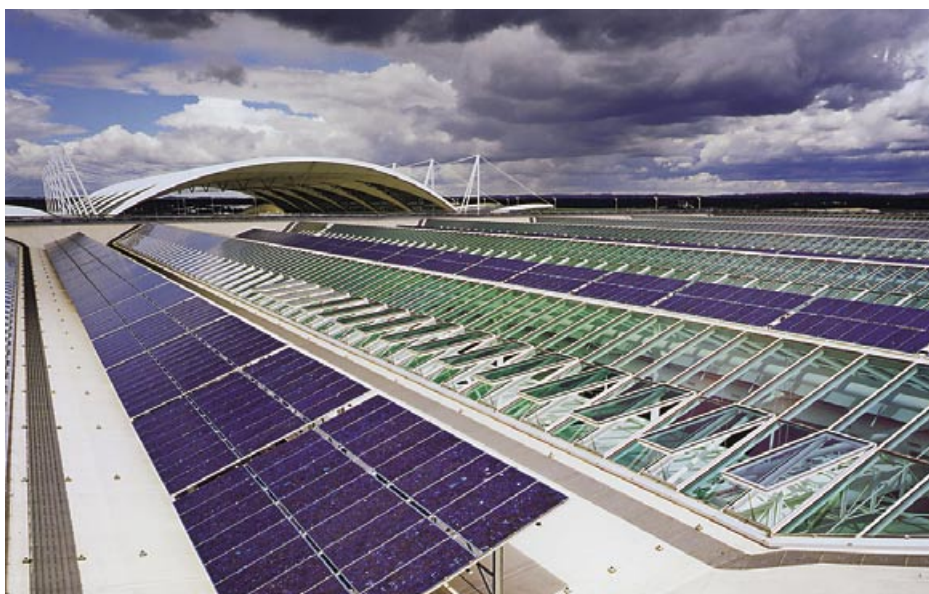
Flughafen München, Terminal 2 – Lamilux RWA-Steuerungstechnik war verantwortlich für die Gesamtprojektierung der in der Halle eingesetzten elektrischen Steuerungstechnik für die natürliche Entrauchung
