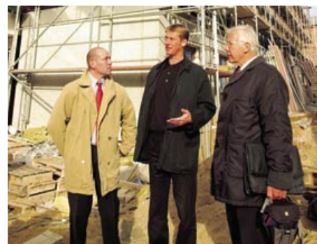
Fred Wolski, Außendienstmitarbeiter von Sikkens Holzbau, Christian Becker vom ausführenden Architekturbüro Guder Hoffend und glaswelt-Autor Jürgen Estrich (v. l.) machen sich vor Ort ein Bild über die Fortschritte der Fassadenmontage
