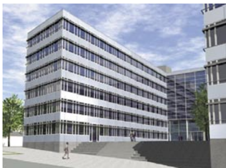
Das Computerbild zeigt die geplante Außenansicht des neuen Büro- und Gewerbezentrum in Hannover-Ricklingen. Hier kommen durchlaufende Fensterbandelemente aus Holz zum Einsatz
