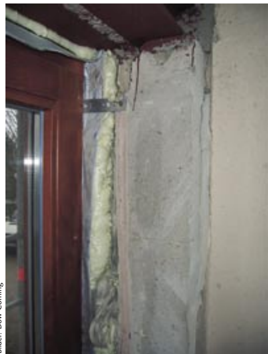
Bild 1: Nicht fachgerechte Ausführung und fehlende dauerhafte Abdichtungsfunktion – leider kein Einzelfall
