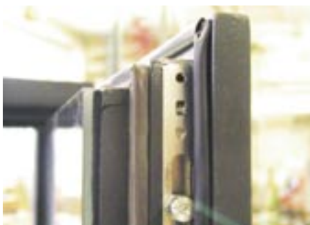
Bild 7: Das Fensterdetail zeigt deutlich die auf den Rahmen geklebte Scheibe. Im Beschlag befinden sich Öffnungen für Ventile zur Gasbefüllung
