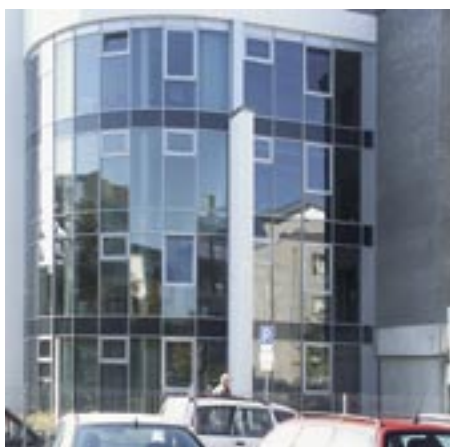
Pfosten-Riegel-Konstruktionen dieser Art weisen geringe Rahmenanteile auf
