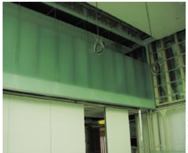
Sichtbare Streifen in der Mitte und am Rand der Bedruckung
