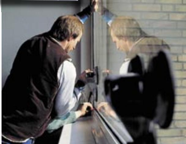
Die Montage des neuen Kombi-Dichtvlies von Würth ist kinderleicht. Nach Abziehen des Schutzpapiers wird das Vlies einfach wie ein Klebeband in die Fenster- oder Türöffnung geklebt
