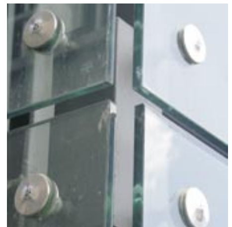
An dieser Fassaden-Ecke ist sehr gut der Randabstand der Bohrungen und die Größe der Klemmteller zu sehen
