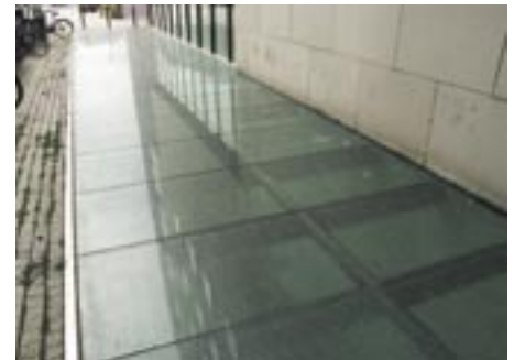
Solche begehbaren Verglasungen können jetzt ohne ZiE ausgeführt werden
