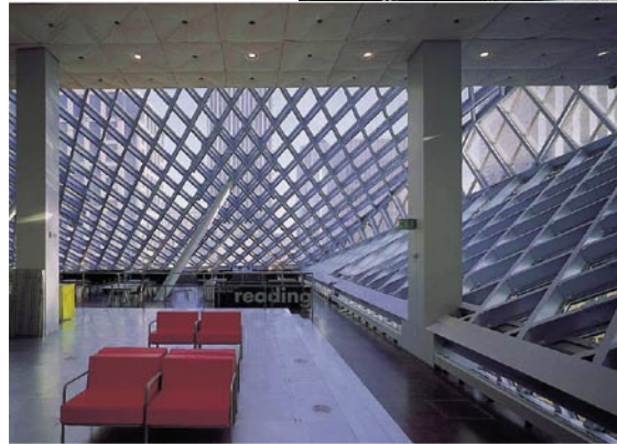
10 000, meist rautenförmige Isolierglaspaneele sind in die Konstruktion eingehängt
