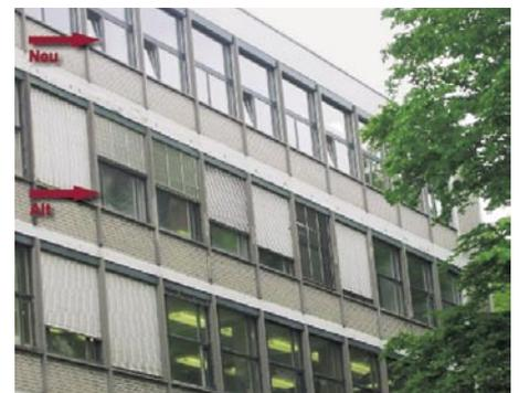
ten Bereichen wie Ganzmetall-Fassadenbau, Automobilbau usw. Der Dämmwert der „Monobloc“-Rahmen beträgt in dieser Ausführung:  $U_f$  (U-frame) =  $< 0,82 \text{ W/m}^2\text{K}$  (eingebaut nach EnEV 2002).
