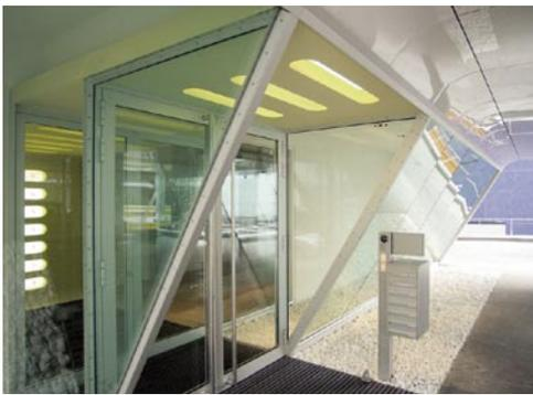
Mit dem neuen Fassadensystem von StoVerotec lassen sich auch abgerundete Fassadendetails umsetzen
