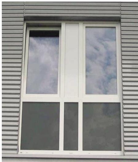
Die Fensterbrüstung im Feuerwehrhaus Gerbrunn enthält Vakuum-Isolations-Paneele
