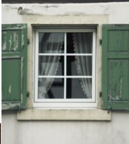
Beim Austausch dieser Scheibe mit „doppeltem Sprossenkreuz“ im SZR ist auf den U g -Nennwert ein Zuschlag von 0,2 W/m 2 K zu machen
