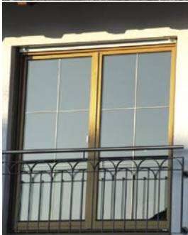
Pech gehabt: Auch ein Messingprofil als Mehrfach-Sprosse in dieser Form führt nach DIN zu einem Zuschlag von 0,2 W/m 2 K
