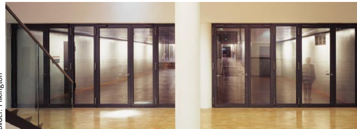
Transparente Brandabschnittsbildung im Übergangstunnel von Haus 5 zu Haus 1 mit einer F 30/T 30-Trennwand-/Türkonstruktion
