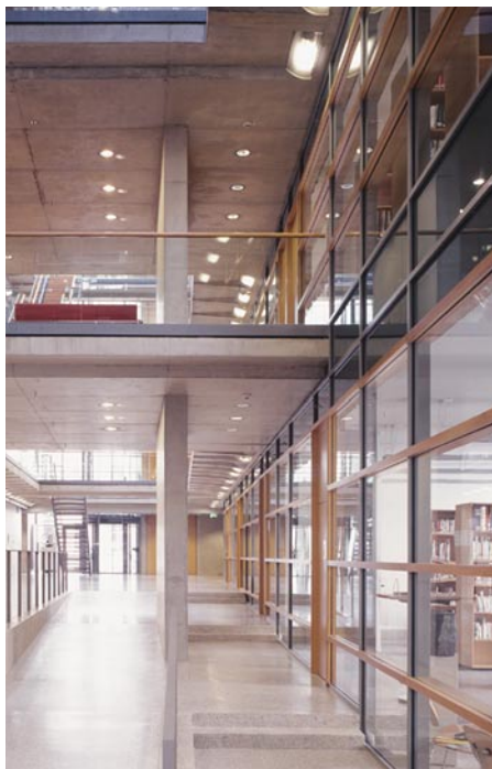
Rechts die F 30-Fassade vor der Dependence der Parlamentsbibliothek mit „Pilkington Pyrostop“/Sonderkonstruktion „Forster therm-fix vario“ in Holz/Stahl-Mischbauweise
