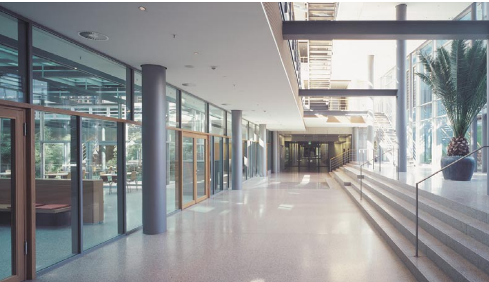
Das Casino in der Ost-/Westhalle von Haus 3 ist zum Fluchtweg hin mit einer G 30-Fassadenkonstruktion mit „Pilkington Pyrodur“ abgegrenzt
