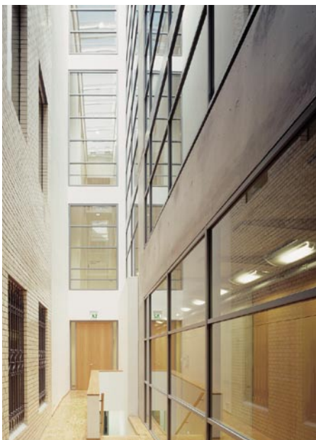
Der Lichthof zwischen dem Altbau (links) und dem Neubau bei Haus 7. Die Verglasungen sind in der Feuerwiderstandsklasse G 30 mit Pilkington „Pyrodur“ ausgeführt
