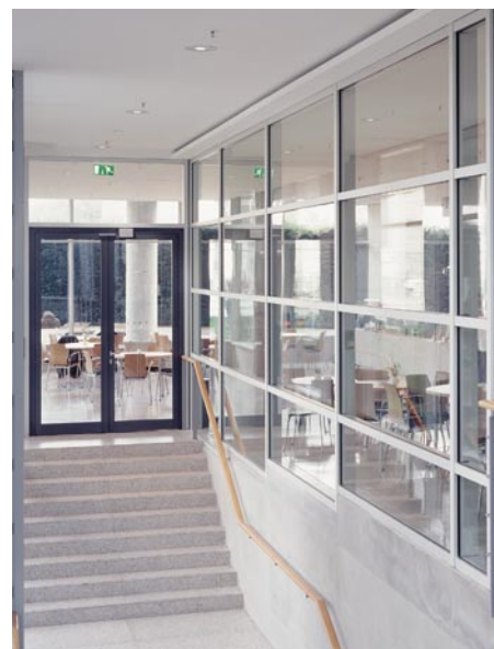
Die F 30-Fassade der Cafeteria ist zur Halle ausgerichtet, die Teil des Flucht- und Rettungsweges ist
