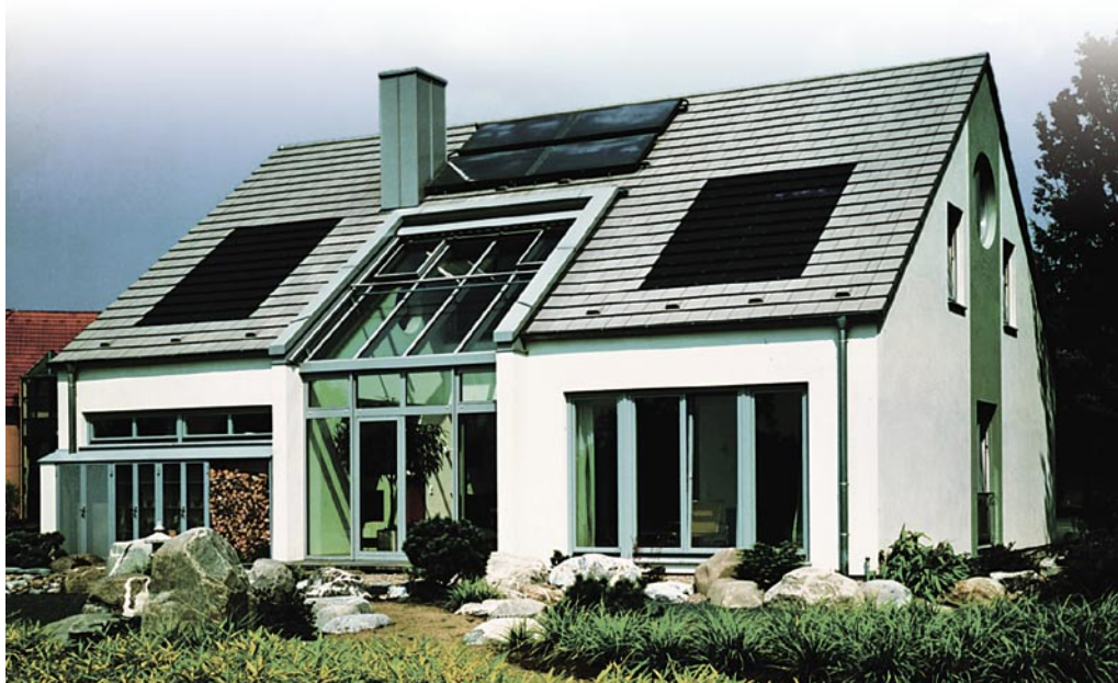
Dachintegrierte Solarmodule sowie Solarkollektoren in Auf-Dach-Montage
