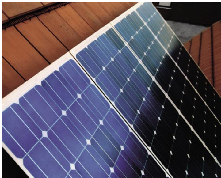
Solarmodule in Auf-Dach-Montage
