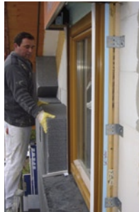
Ganz entscheidend für den Schall- und Wärmeschutz beim Fenster: der fachgerechte Einbau (fugendicht und wärmebrückenfrei)
