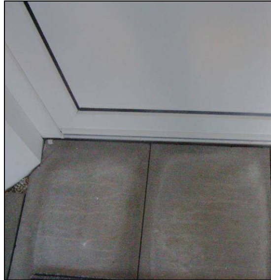
Abb. 2.5.5-2: Anschluss Wohnungseingangstür
