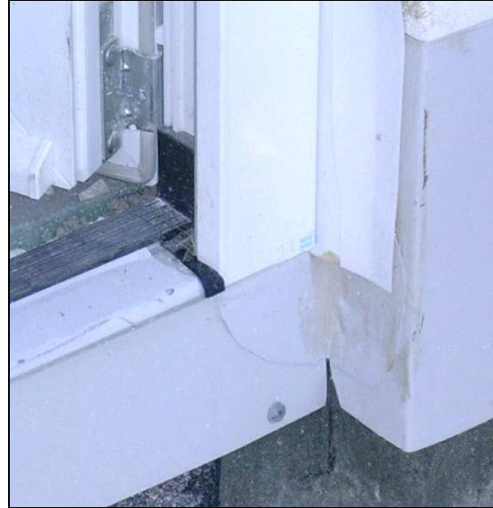
Abb. 2.5.8-2: Detail Ausführung Verbundblech im Bereich der Leibung
