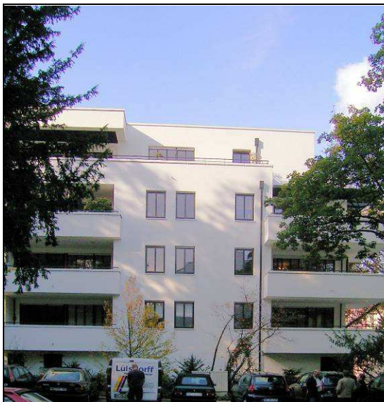
Abb. 2.5.3-1: Seitenansicht der Wohnanlage
