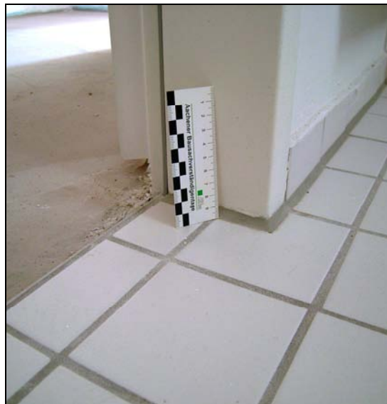
Abb. 3.5.3-2: Übergang Bad/ Flur, im Flur ist noch keine Nutzschicht verlegt
