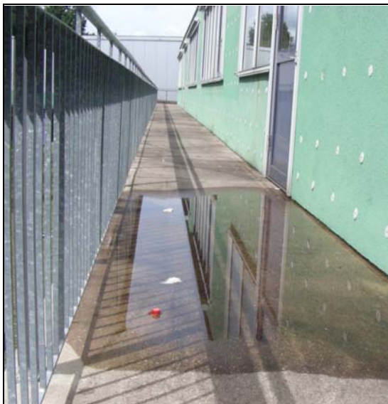
Abb. 2.3.5-1: Pfützenbildung auf dem Balkon
