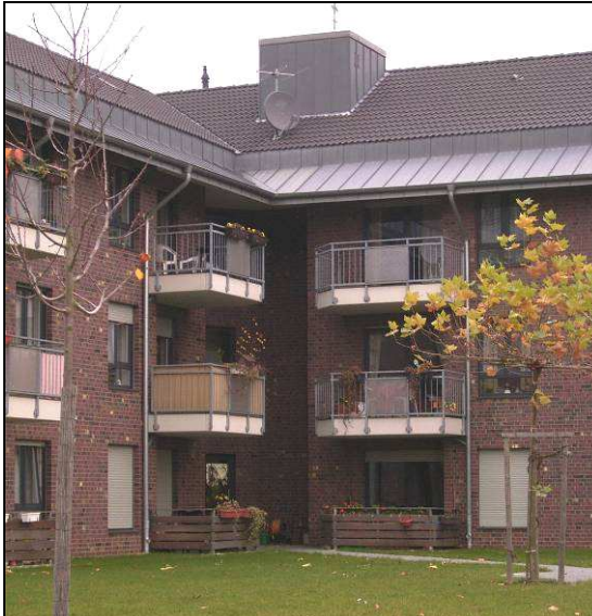
Abb. 2.5.6-1: Ansicht der untersuchten Balkone
