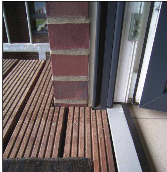
Abb. 2.5.6-2: Detail Balkonschwelle
