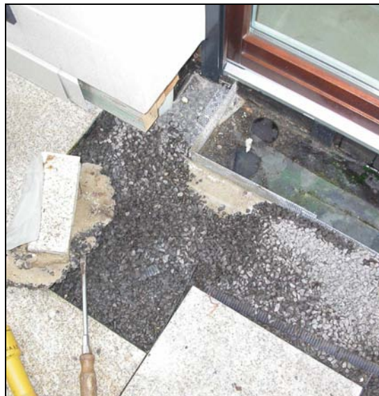
Abb. 2.3.4-2: Anschluss Türleibung
