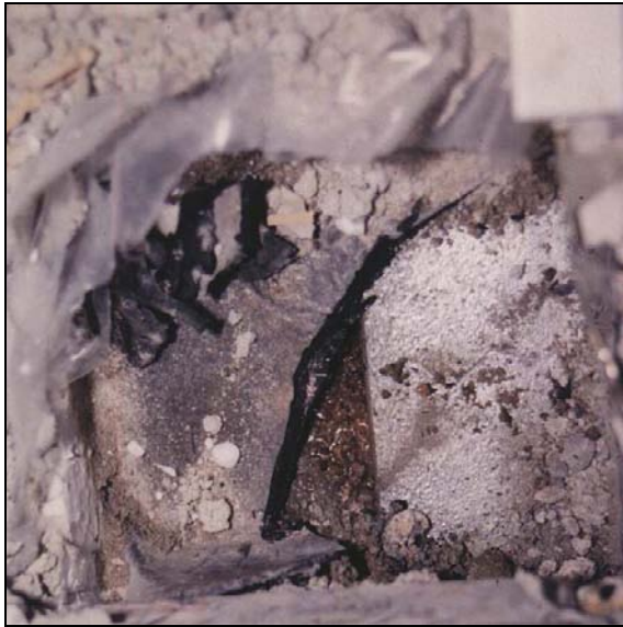
Abb. 3.3.3-4: Aufkantung der Abdichtung im Bereich der Türzarge
