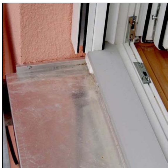
Abb. 2.5.7-4: Anschluss Balkon/ Fenstertür
