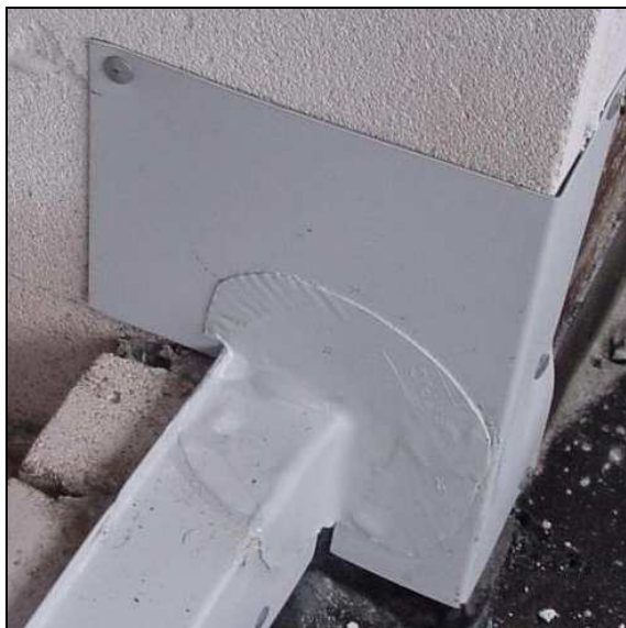
Abb. 2.5.8-4: Lage Verbundblech vor Einbau der Türanlage
