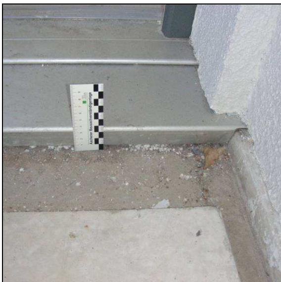
Abb. 2.5.2-4: Schwellensituation nach Entfernung des Gitterrostes im Bereich der Türschwelle
