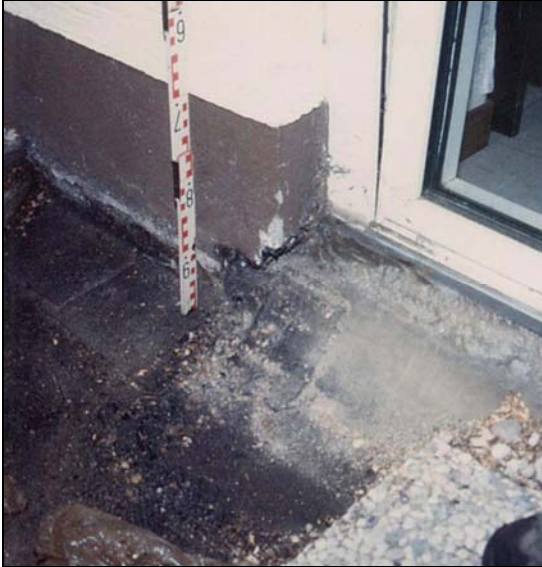
Abb. 2.3.6-1: Übersicht zum Türanschluss nach Entfernen des Belags
