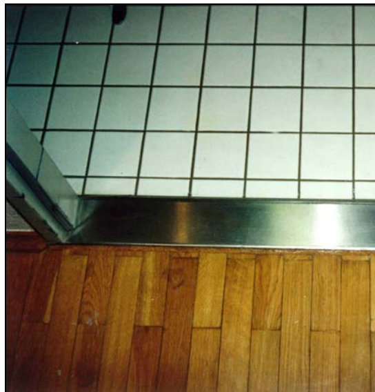
Abb. 3.3.2-2: Detail Türschwelle
