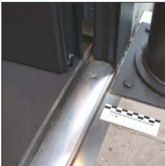
Abb. 2.6-6: Türschwelle im eingebautem Zustand
