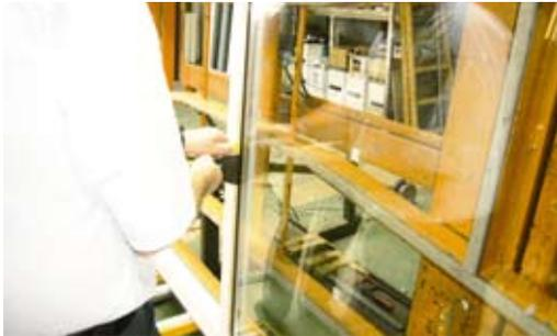
Die fachgerechte Klotzung sichert die optimale Einbaurage der Scheibe
