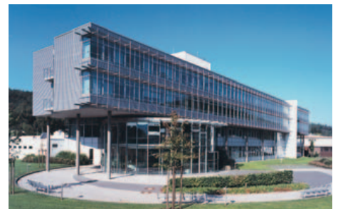
Verwaltungsgebäude SIEGENIA-AUBI, Wilsdorf.
